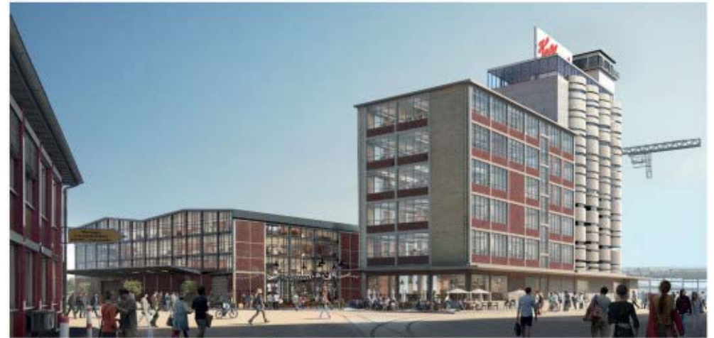
Ansicht Silo mit Vitaminlager und dem benachbarten Reislager
